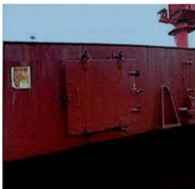
图 1-自然通气孔外观
